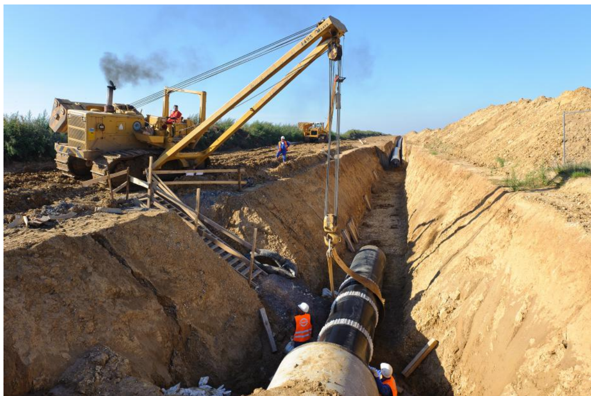
Passage d'une portion de gazoduc dans un tunnel pour le franchissement d'une route– Photographie MEEM
