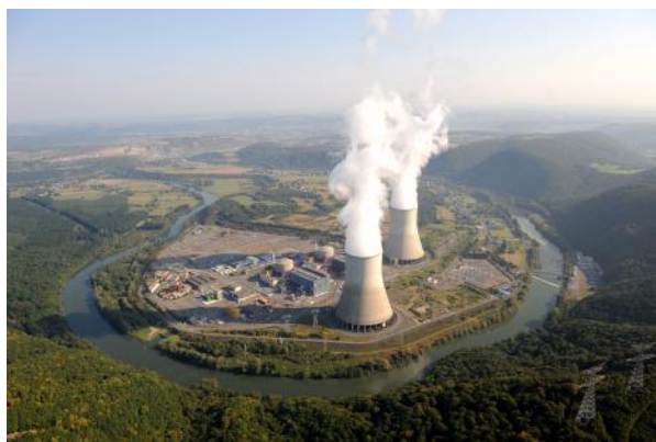
Centrale nucléaire de Chooz dans les Ardennes Photographie EDF
