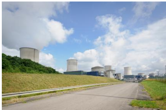
Centrale nucléaire Cattenom en Moselle Photographie issue de la Photothèque du MEEM
