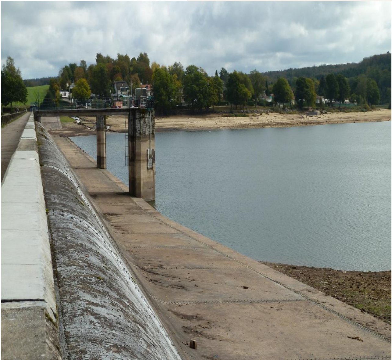
Barrage de Bouzey (88) – Photographie DDT88
