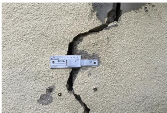
Témoin de fissuration d'une habitation suite à un retrait-gonflement argileux – Photographie MEEM
