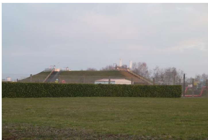
Stockage de gaz de la Société Finagaz à Golbey - Photographie DDT 88
