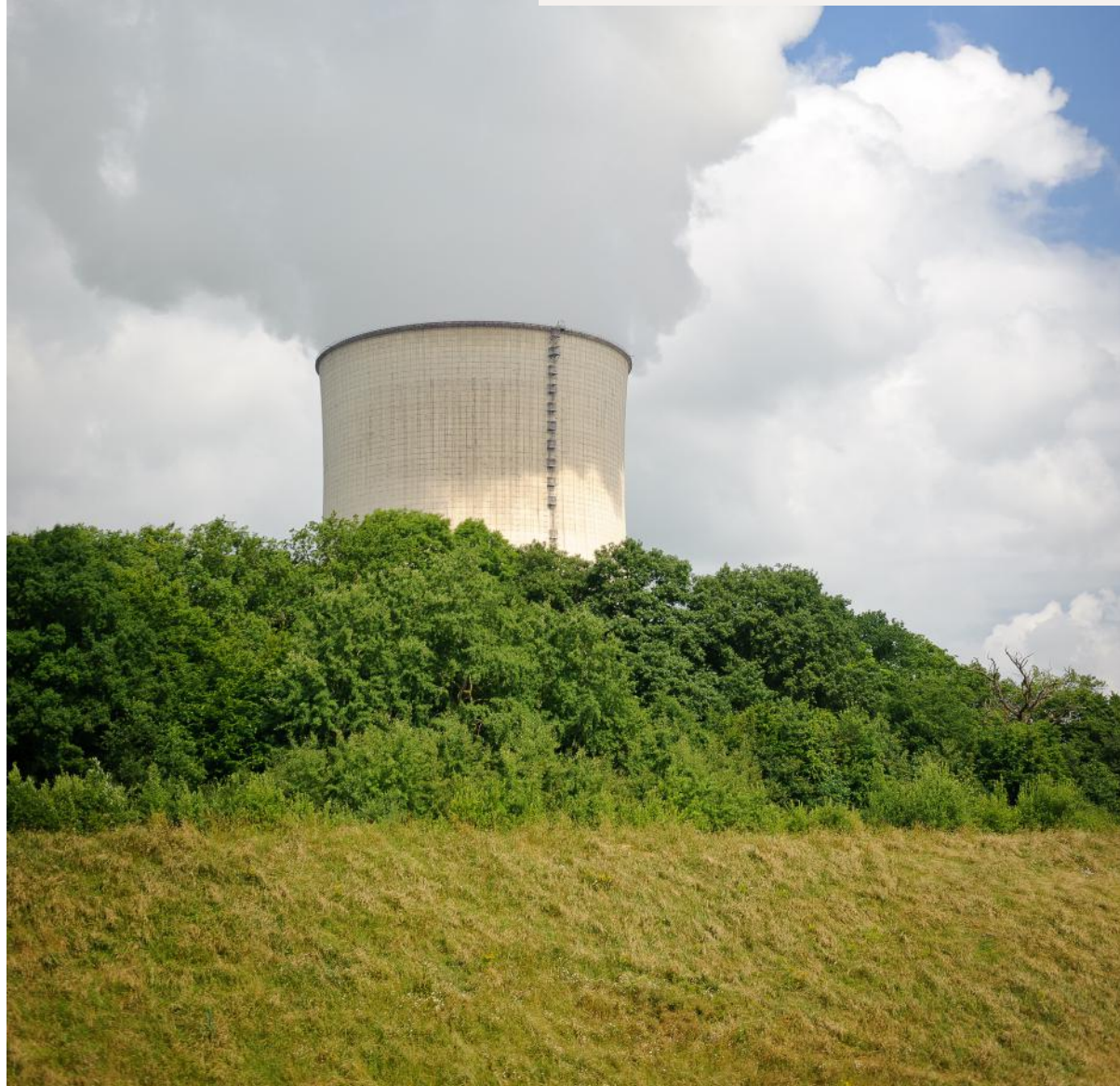
Centrale nucléaire Cattenom en Moselle Photographie issue de la Photothèque du .MEEM
