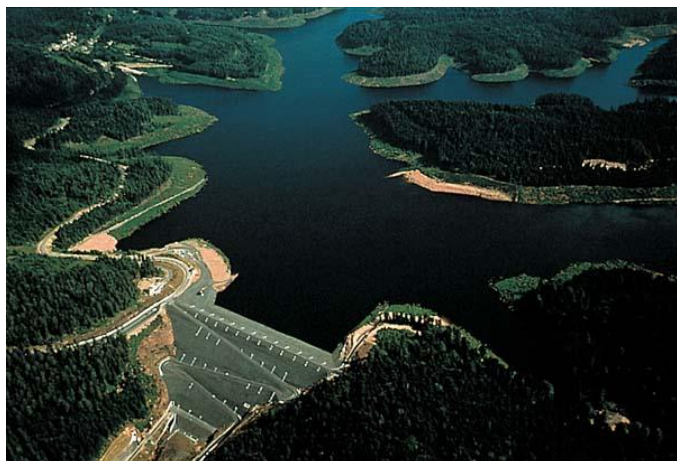
Barrage de Vieux-Pré à Pierre-Percée (54) – Photographie Wikipédia
