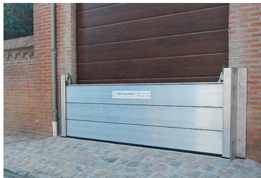
Dispositif de protection individuelle des crues : Batardeau - Photographie
